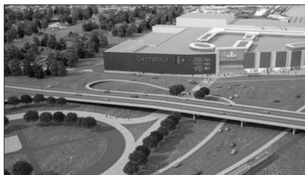
Centrul comercial Korona va avea inițial o suprafață de 35.000 mp
