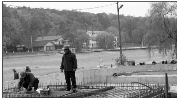
Până acum a fost turnată doar fundația blocului
